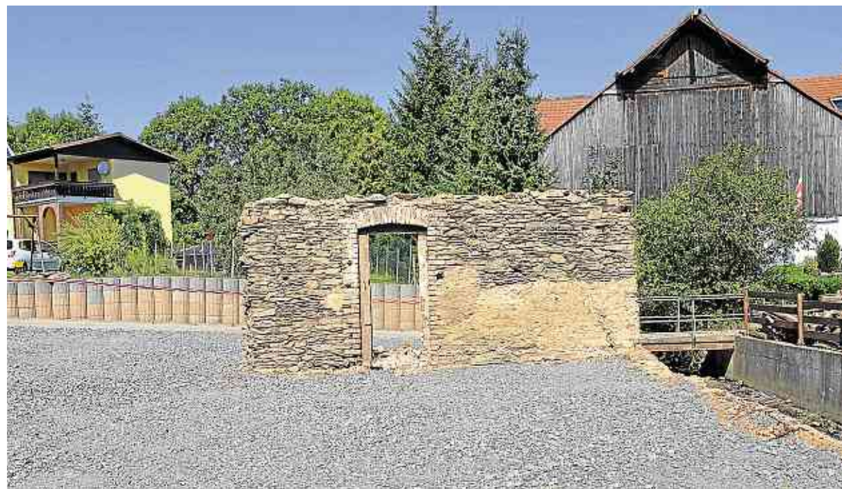
Das Haus Soonwaldstraße 14 ist abgerissen, die Fläche soll zur Dorfmitte umgestaltet werden. Die Frage ist, ob mit der oder ohne die verbliebene Bruchsteinmauer?
